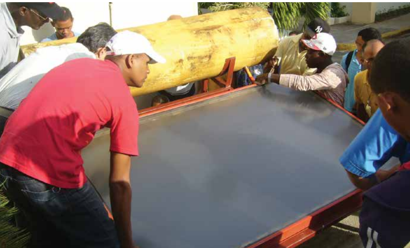
Instalación de paneles solares en un hotel, República Dominicana
